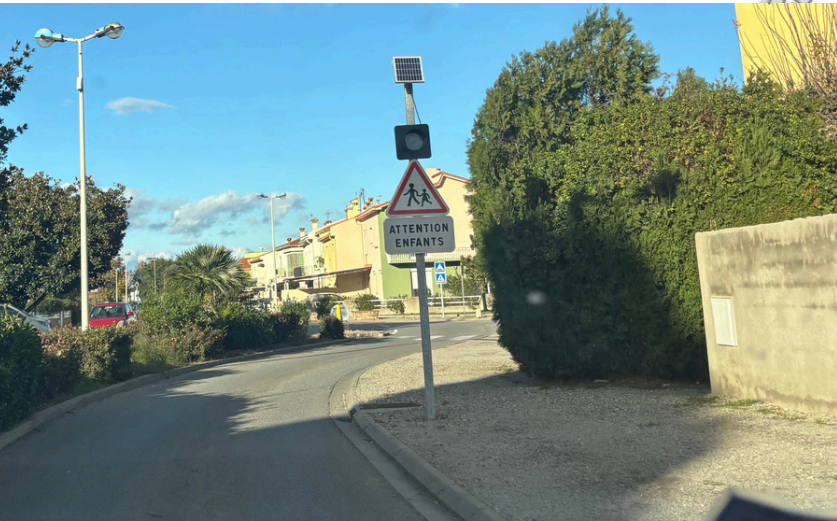
Présence de signalisation "Attention aux enfants" et passage piéton et absence de trottoirs continus
