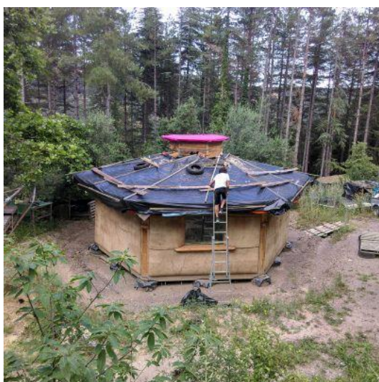
Figure 28 : Photographie des travaux de construction du toit du Flexagone.
