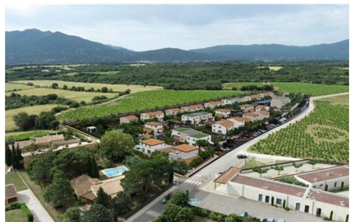
Figure 18 : Photographie de l'écoquartier de Tresserre. Source : Turbines et Municipalité de Tresserre
