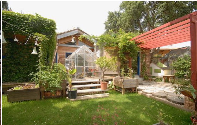
Figure 25 : Photographies après-projet de la construction de la Maison Bois, Terre, Paille. Source : Laurant A.
